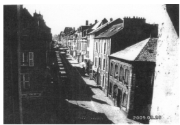
シャルルビルの町並み
